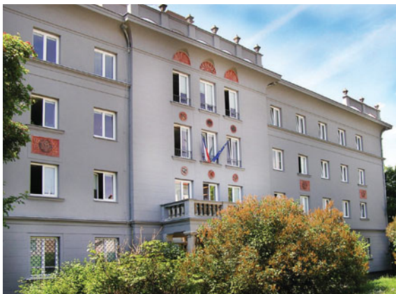
Obr. 58: Fotografie sídla ústředí ČŠI v Praze
