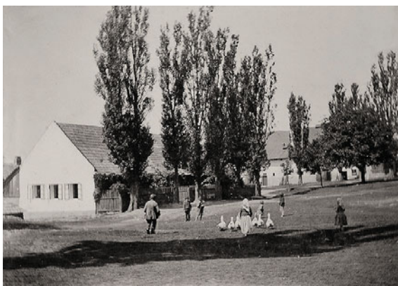
Obr. 35: Ukázka venkovské školní budovy z 2. poloviny 19. století (škola ve Větrném Jeníkově)
